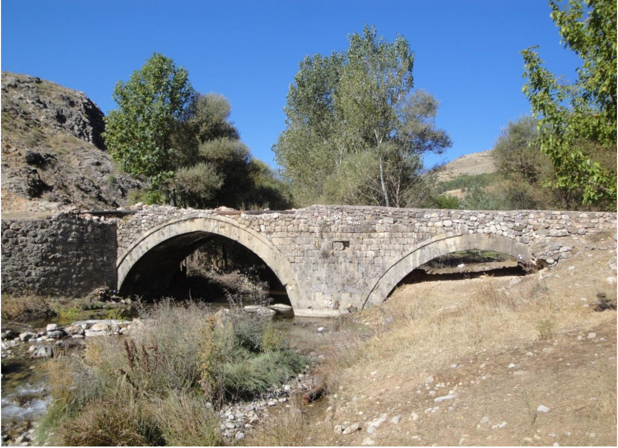
Resim 7. Tarhanik Köprüsü, Restore Öncesi Mansap (Cumali Levent, Arapgir 2011).
