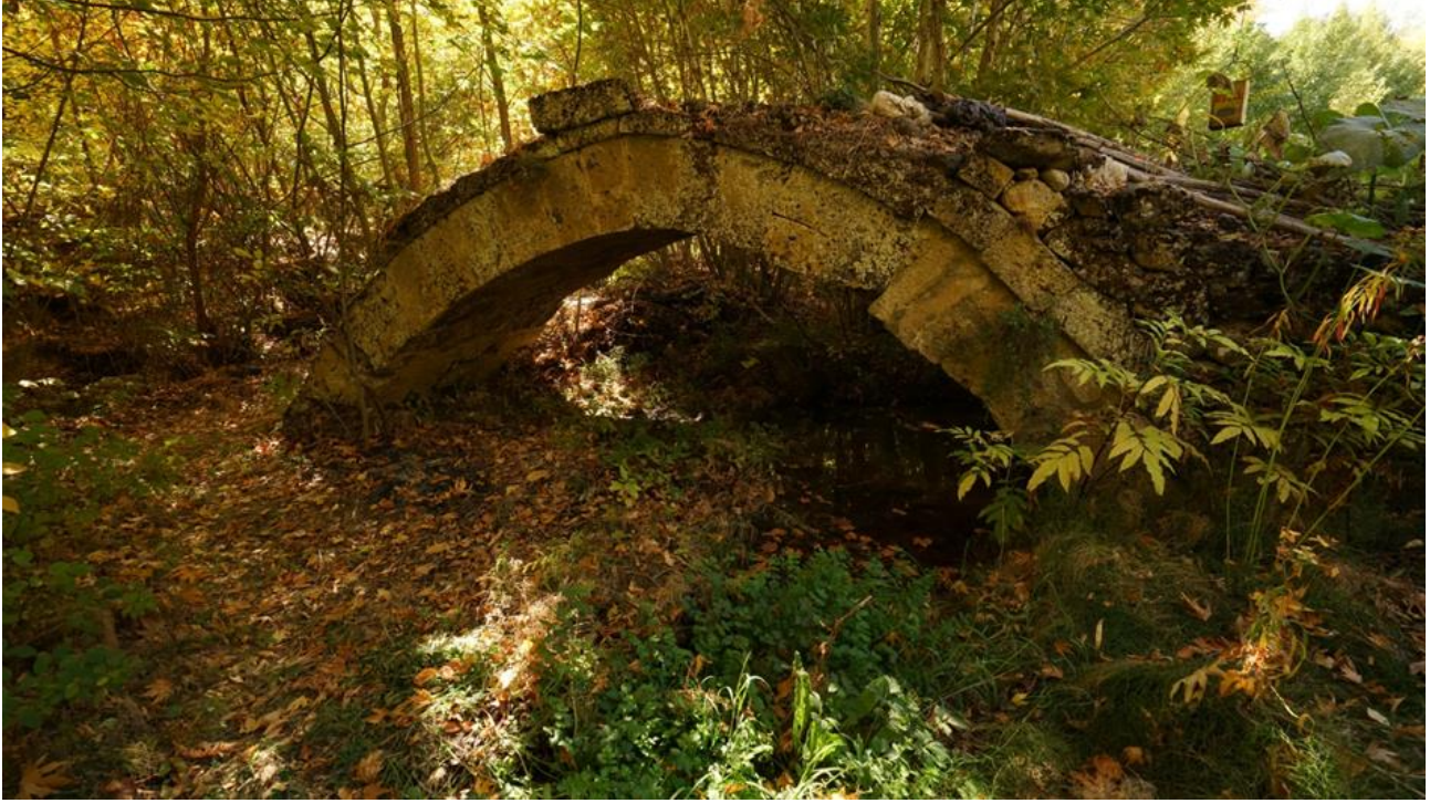
Resim 15. Eskişehir Karşı Köprüsü, Mansap (Cumali Levent, Arapgir, 2021).
