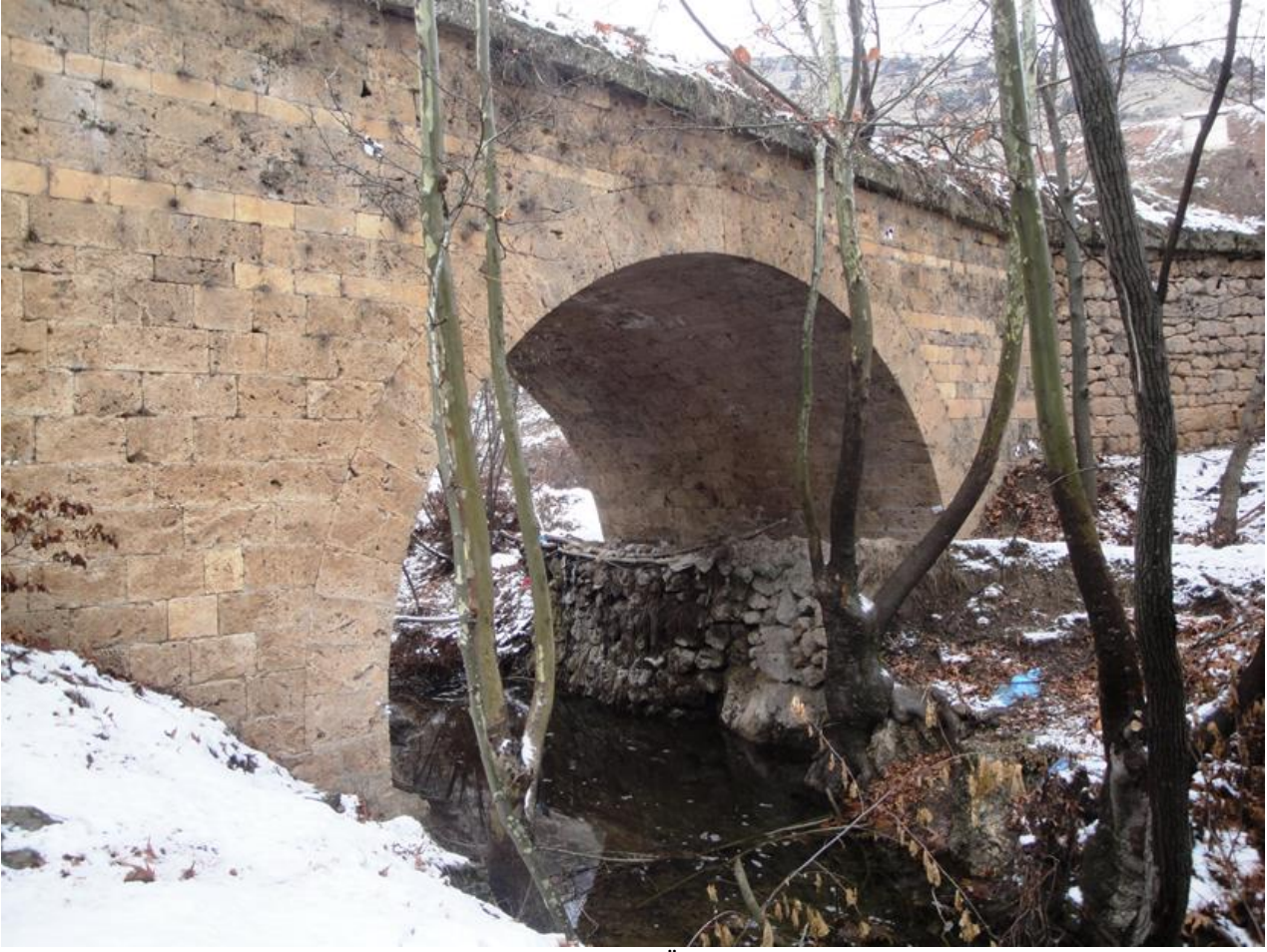
Resim 12. Kozluk Köprüsü, Memba Restore Öncesi (Cumali Levent, Arapgir.2012).
