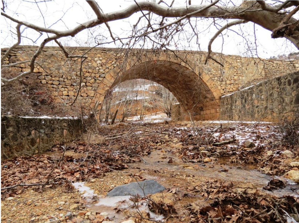
Resim 18. Vavilik Köprüsü, Restore Öncesi Mansap (Cumali Levent, Arapgir, 2011)
