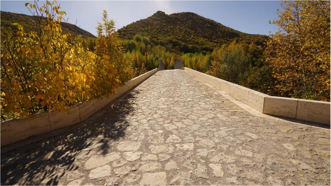
Resim 13. Kozluk Köprüsü, Döşeme (Cumali Levent, Arapgir2021).
