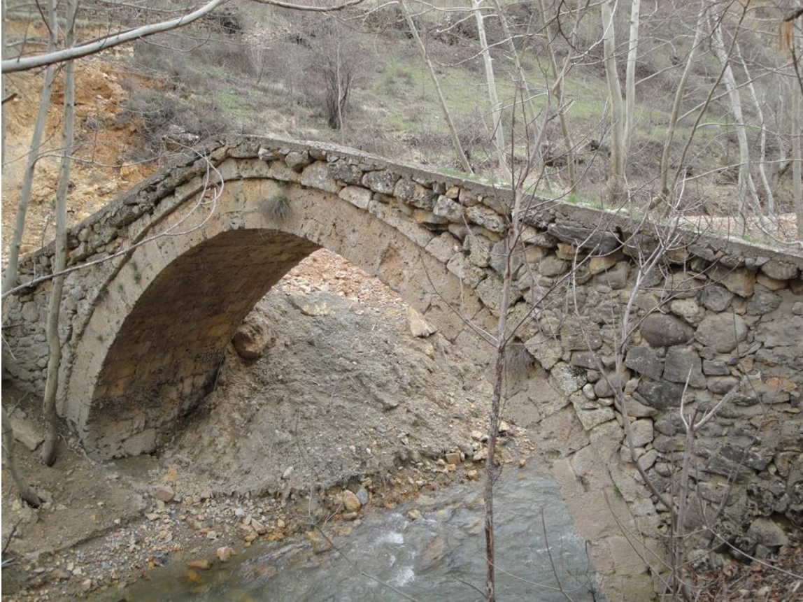
Resim 9. Kale Köprüsü, Mansap Restore Öncesi (Cumali Levent, Arapgir, 2011).
